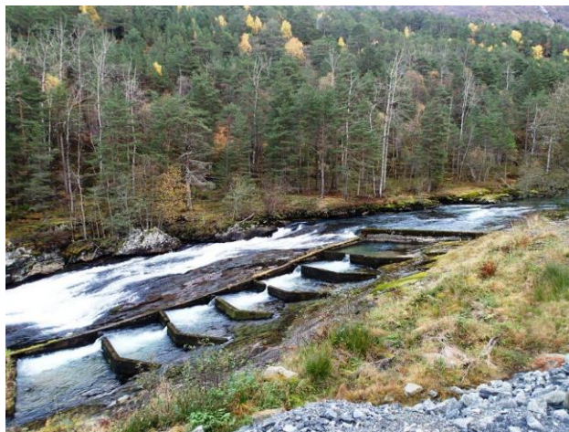
Figur 3. Den øverste fisketrappen i Korsbrekkkelva.
