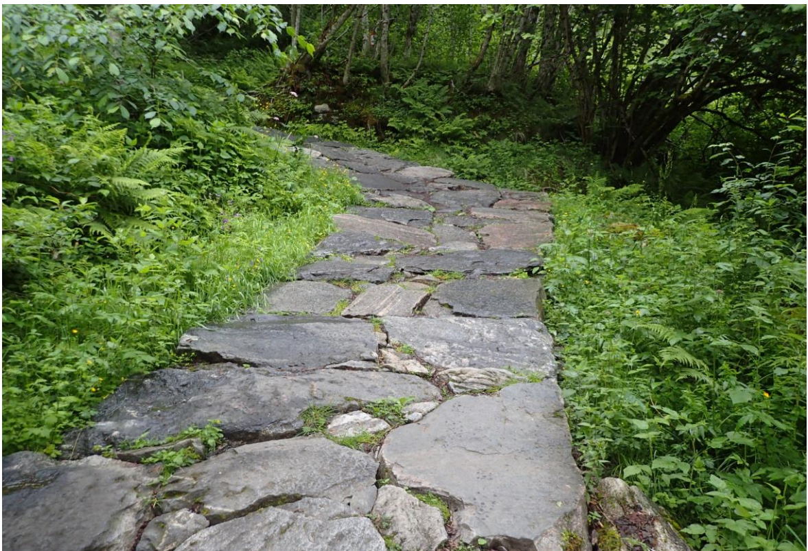
Figur 18. Enda et eksempel på godt utført steinhellelegging i Mørkja.
