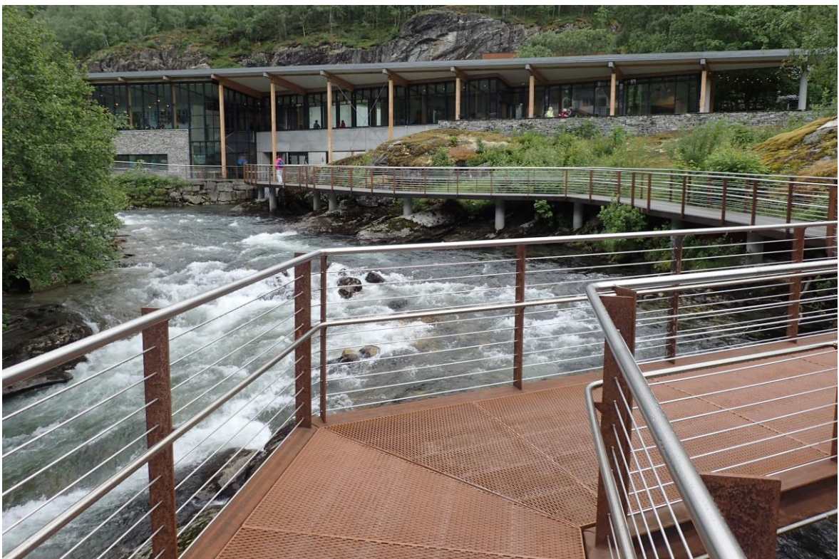
Figur 11. Gangbruer av metall opp til Norsk Fjordsenter.
