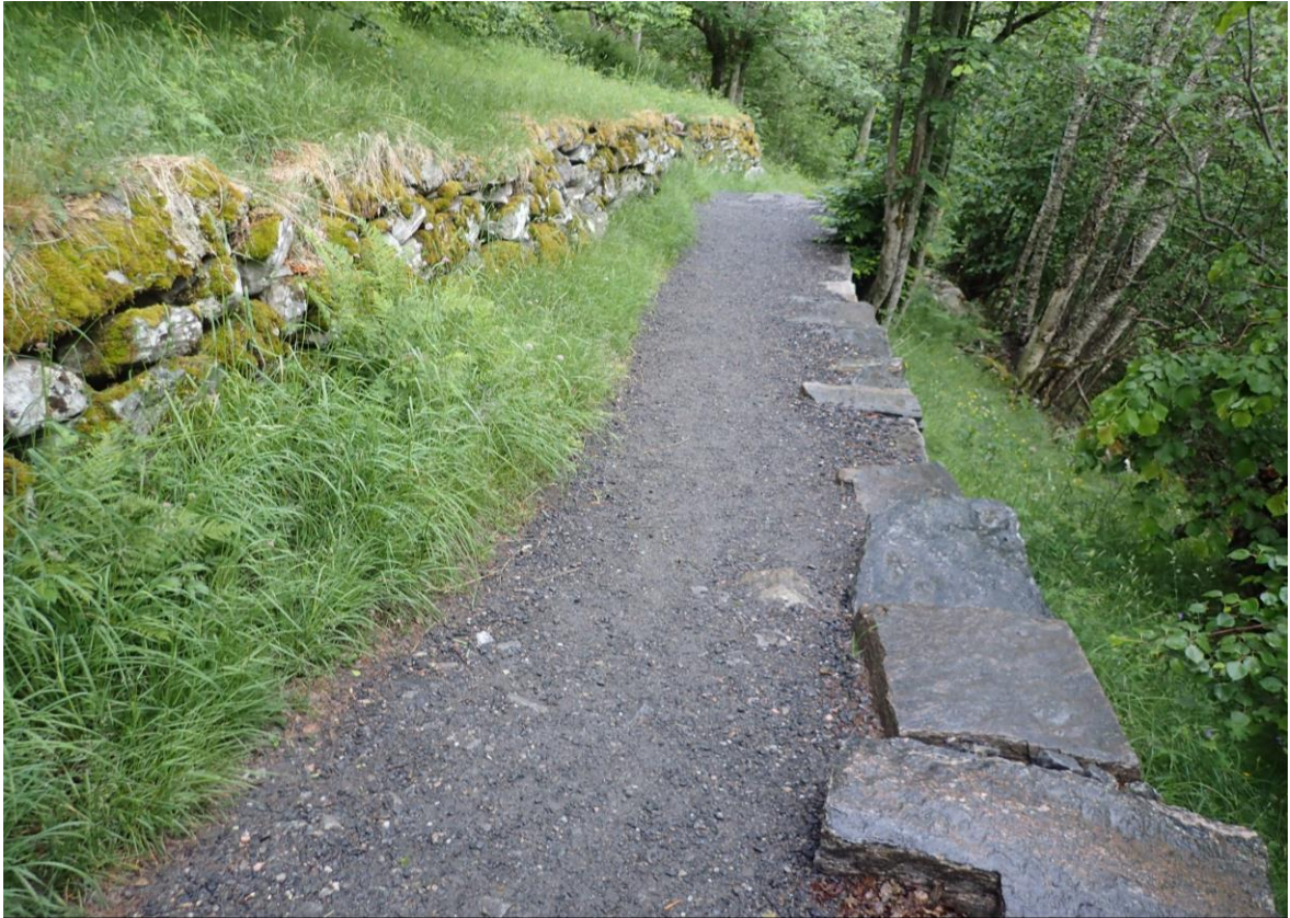
Figur 19. Her er vi kommet opp til innmarka på Vesterås. Stien er oppmurt i nedkant, gruslagt og forsterket med steinheller i kanten, nedenfor en gammel steinmur.
