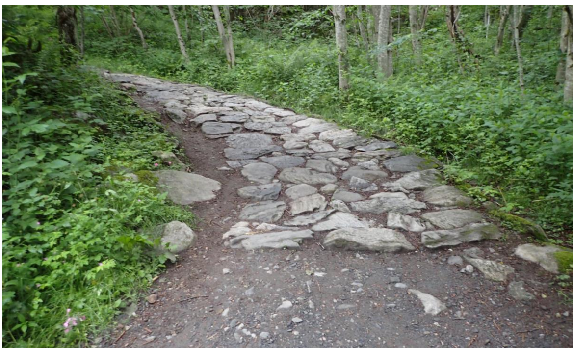
Figur 14. Stien gjennom skogen i Mørkja opp til Vesterås veksler mellom grusvei, steinhellelegging som her og steintrapp. Her vises overgang fra grus til steinheller. Steinhellene er effektive for å hindre erosjon av både vann og tråkk, men er hardere å gå på, og også noe mer ujevne enn grus.
