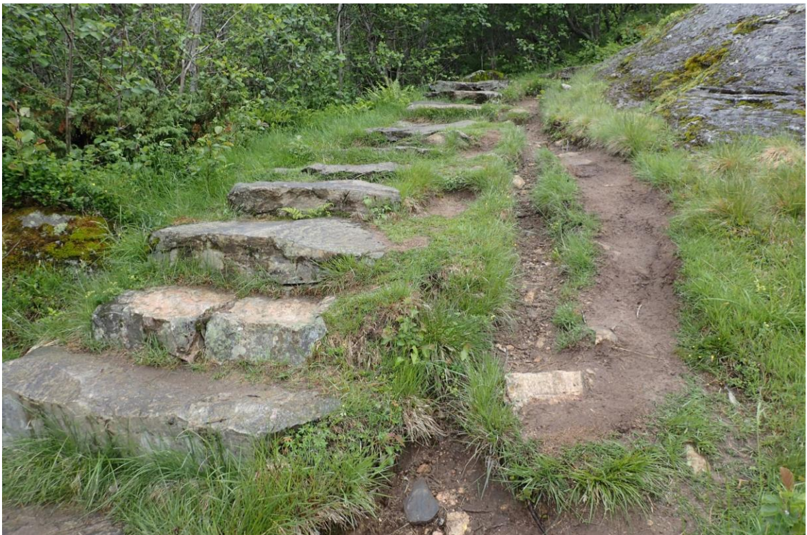
Figur 30. Steintrapper ovenfor Liastølen, med sti på naturlig underlag ved siden av. Tiltak kan vurderes, for eksempel bredere steintrapper eller oppgrusing ved siden av trappa.
