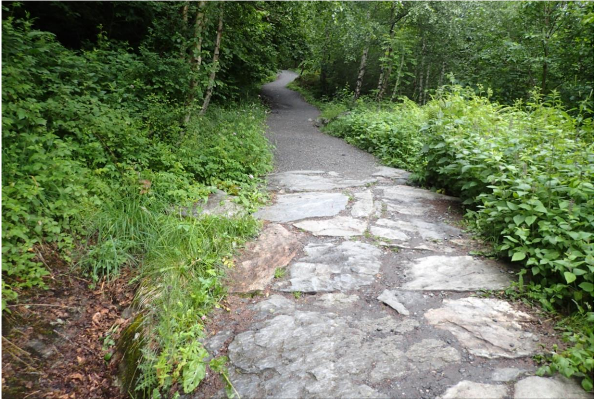
Figur 15. Overgang fra steinheller til grusvei igjen i Mørkja. Grusunderlaget virker så langt nokså stabilt. Det er viktig å ha kontroll på vannet (grøfter, stikkrenner).
