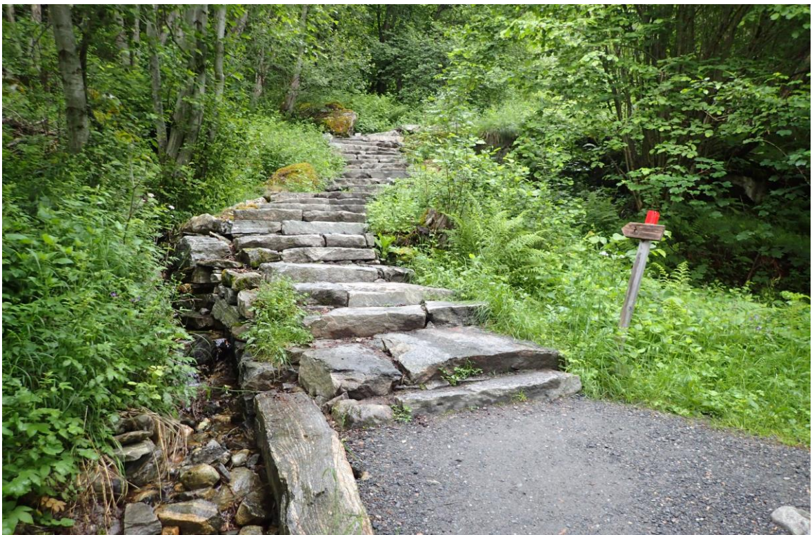
Figur 16. Her går stien fra grusvei til steintrapper i et brattere parti. Veien er godt sikret mot erosjon og tilpasset det store antallet besøkende.
