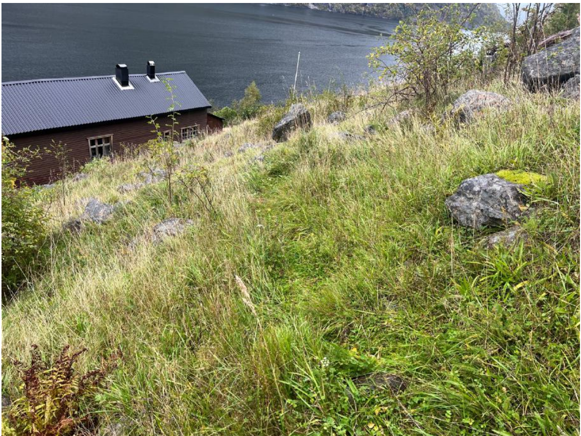
Figur 25 Enga gror igjen med dødt gras og oppslag. Det bør ryddes for oppslag og fjernes noe stein, samt at det bør slås én gang på sensommeren og helst beites.
