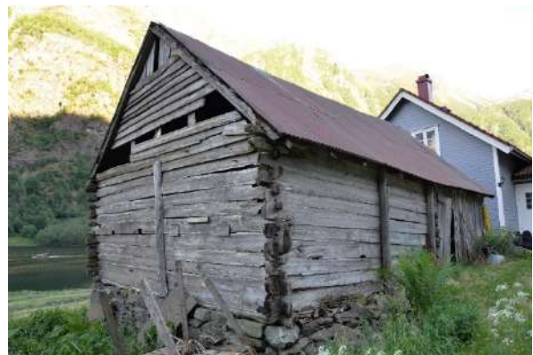
Figur 89. Driftsbygningen på bruk 6 i 2018.
