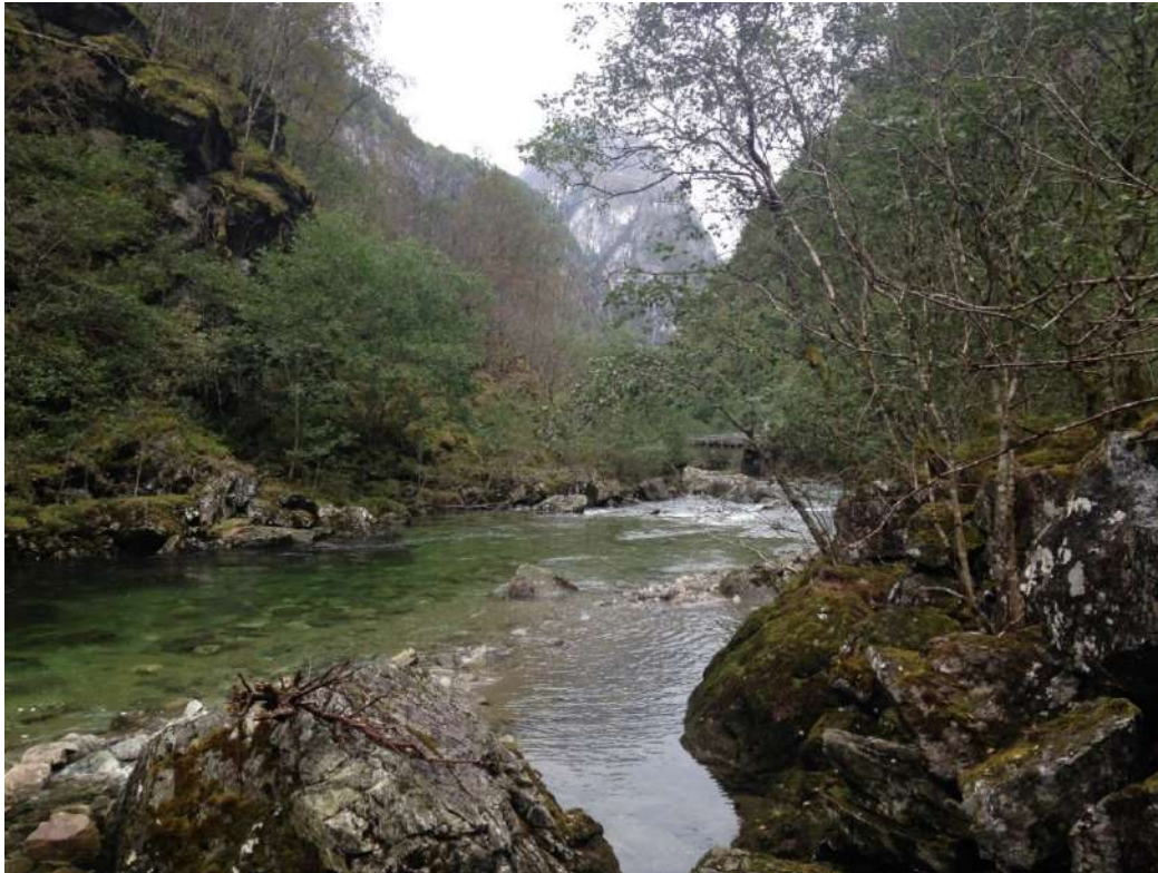
Figur 79. Parti frå den gamle postvegen der den kryssar elva og går opp til Stalheim. Den opphavlege brua er gått tapt, men brukara er bevart. I bakgrunnen er den nye brua over elva. Foto Arlen Bidne/VLFK 2019.
