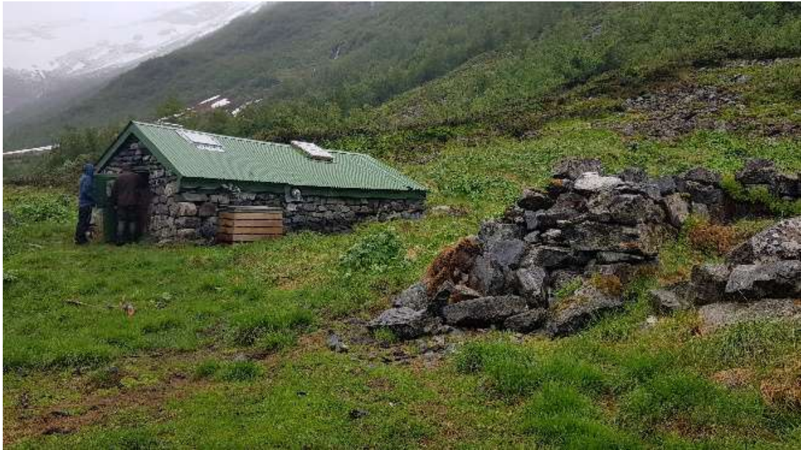
Figur 84. Stølshus på Lintu. Foto: Jorunn Vallestad, 2020
